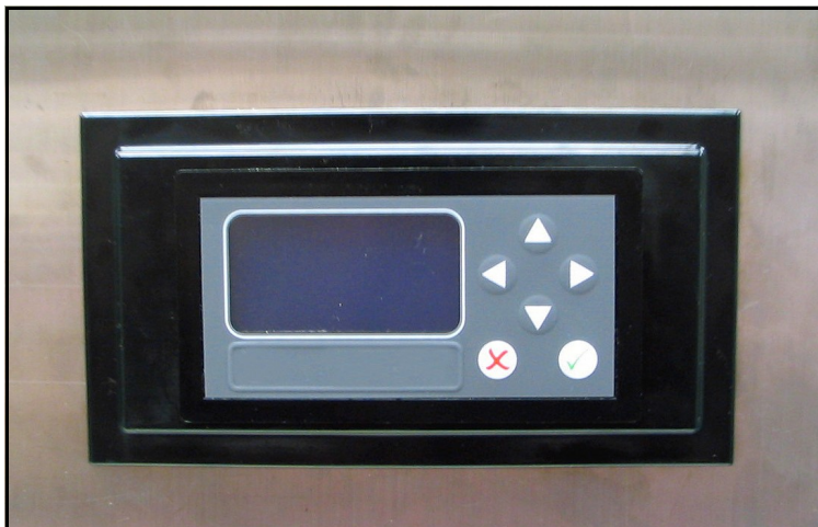
Figura 22: Installazione dell'igrometro a canale unico con piastra adattatrice - Lato anteriore
