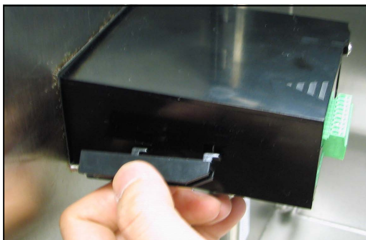
Figura 12: Instalación de los soportes de montaje
