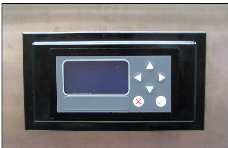
Figura 22: Instalación del higrómetro - Vista frontal
