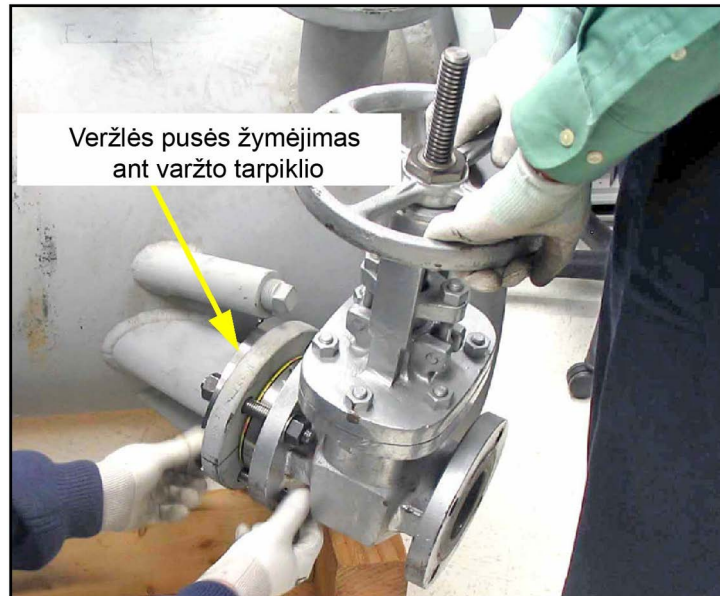
5 pav.: Atskyrimo vožtuvo montavimas
