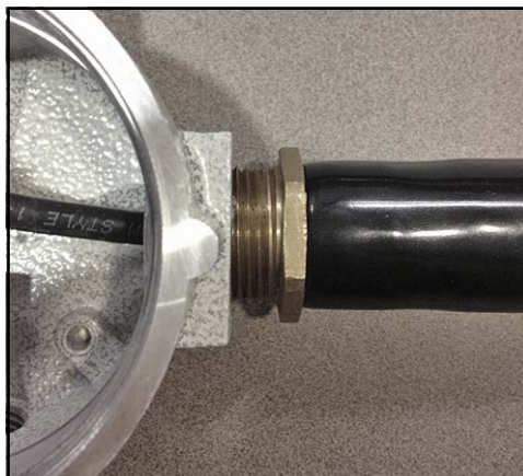
Figura 9: Ajuste del prensaestopas
