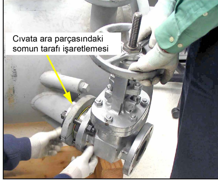
Şekil 5: İzolasyon Vanasının Montajı
