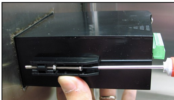
Figura 14: Fijación del analizador dew.IQ en el panel
