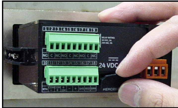
Figura 48: Tirar de la cubierta flexible
