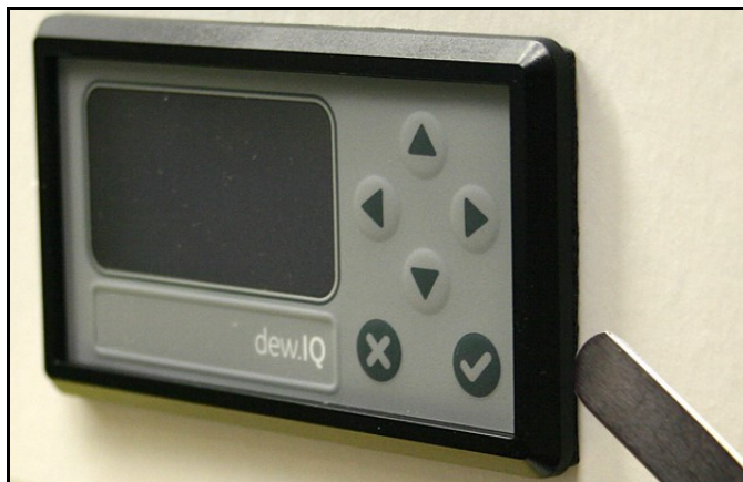
Figura 15: Verificación de la compresión de la junta
