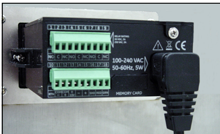
Рисунок 32: Установка кабеля питания переменного тока
