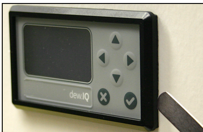
Рисунок 15: Проверка сжатия прокладки
