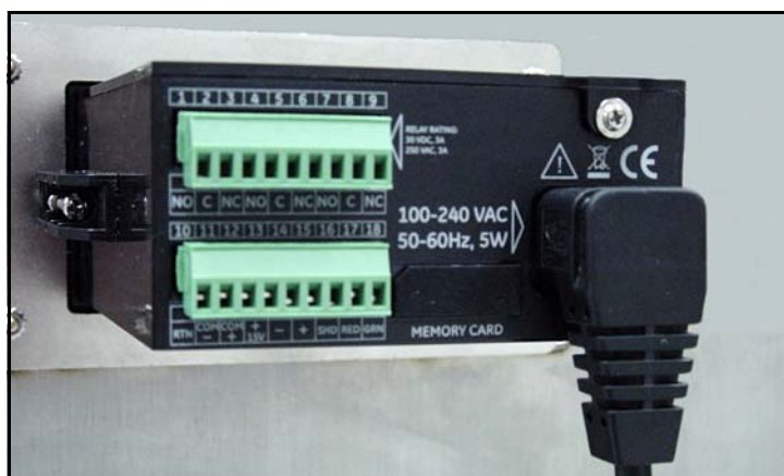
図 32：設置された AC 電源ケーブル
